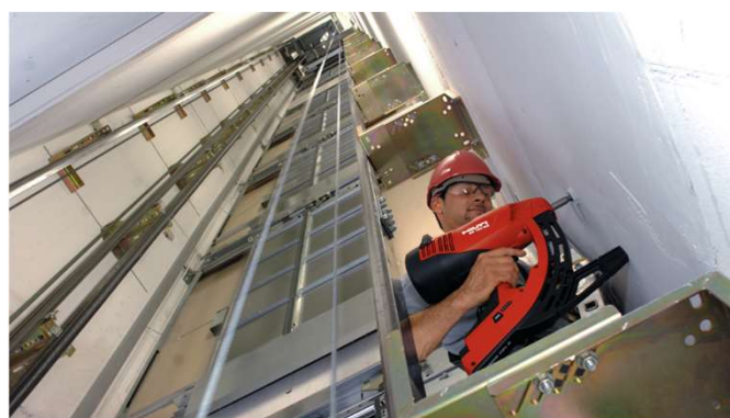
Lắp đặt thiết bị thang máy
